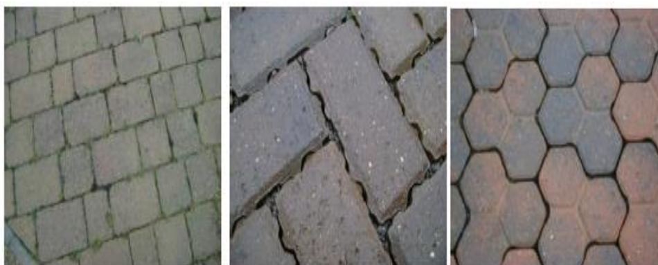
Figura 3 - Tipos de pavimentos semipermeáveis.
