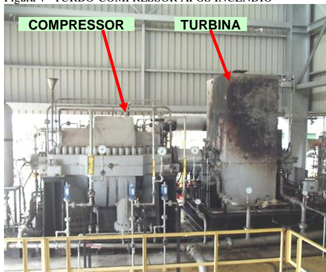
Figura 4 –TURBO-COMPRESSOR APÓS INCÊNDIO
