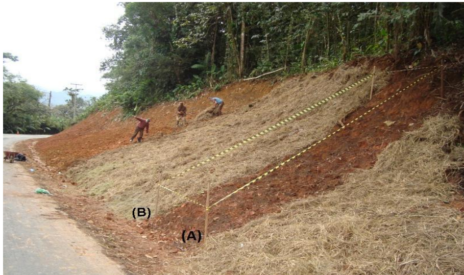
Figura 1: Aplicação da palha (área A: sem palha e área B: com palha).
