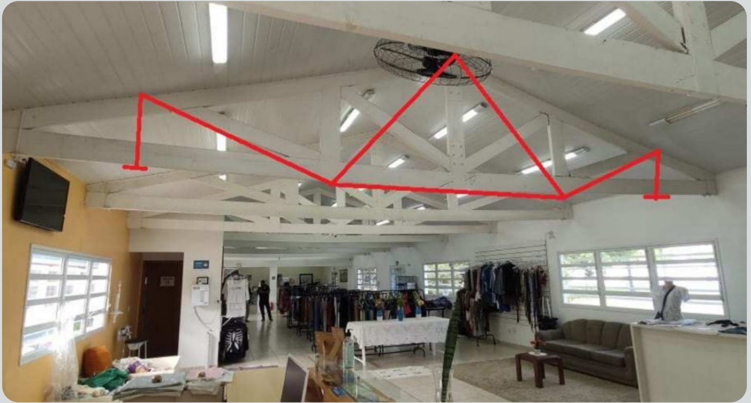
Figura 24: Exemplo de reforço das ligações com tirantes.
