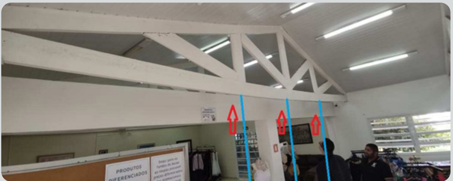
Figura 22. Exemplo de escoramento das treliças.
