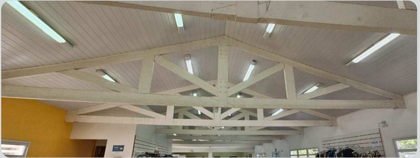
Figura 1: Treliças da cobertura do Lar dos Idosos Recanto do Tarumã.
